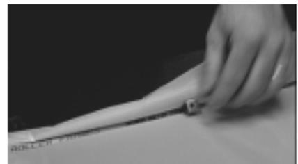
**5.- Aflojando las esquinas:** *¡Antes de tensar, asegúrese de aflojar las esquinas!* Esto evitará que la malla se rasgue durante el proceso de tensar.
